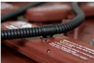
Tubería sin abrazaderas
